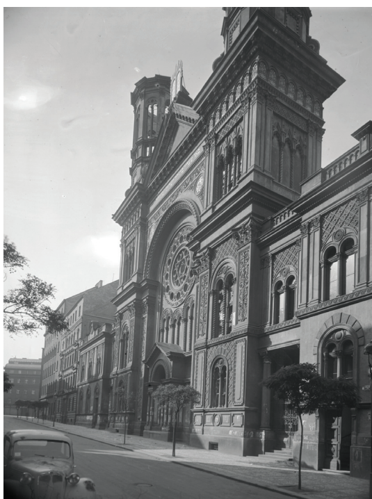
Vinohradská synagoga krátce před zbořením, 1950. Vinohrady Synagogue shortly before demolition, 1950
