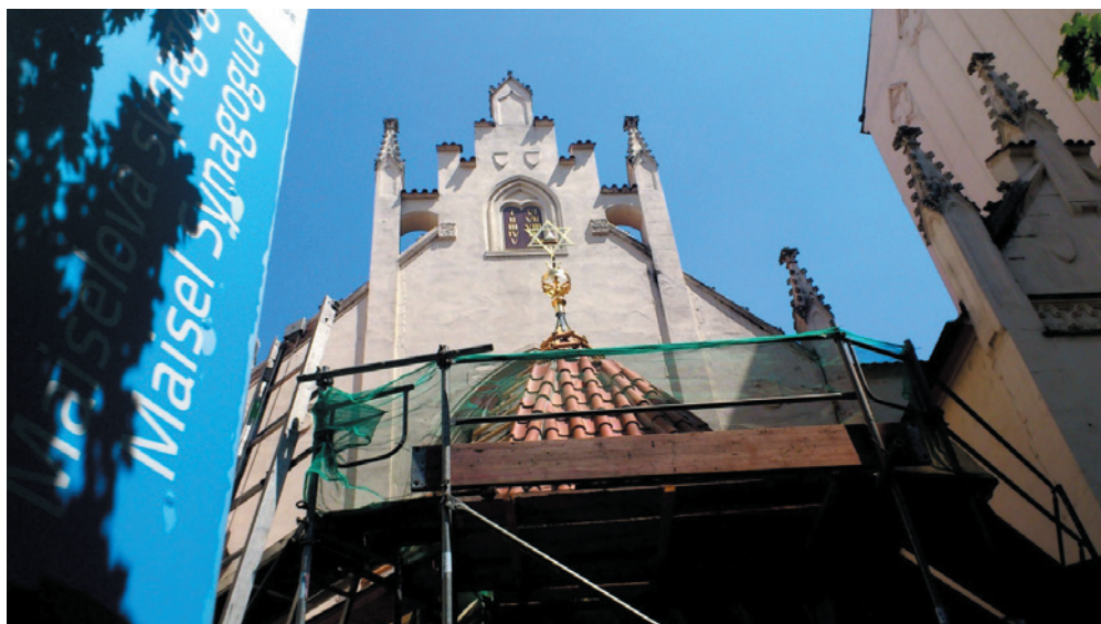
Rekonstrukce Maiselovy synagogy probíhá od dubna 2014
