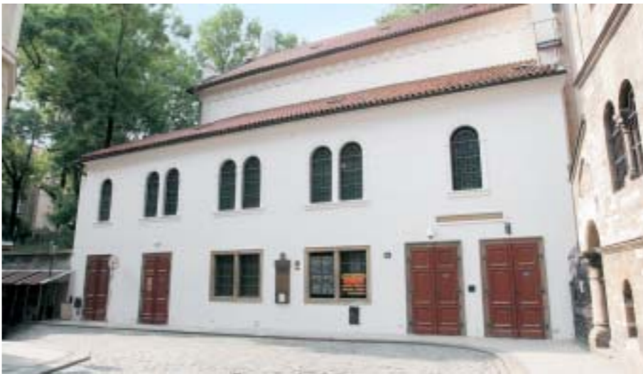
Celkový záběr na čelní stranu opravené Klausové synagogy. Overall view of the front side of the refurbished Klausen Synagogue.
