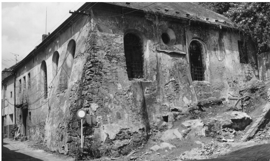
Zadní synagoga v Třebíči z roku 1669 před zahájením obnovy. The Rear Synagogue in Třebíč (1669) before renovation
